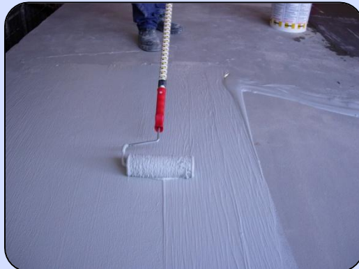
3. Impermeabilizzante tal quale in due mani
