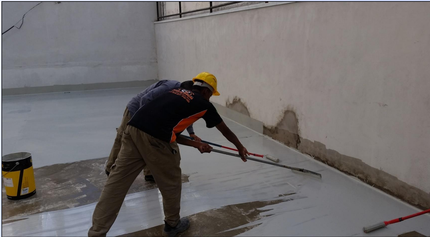
3. Applicazione dell'impermeabilizzante
